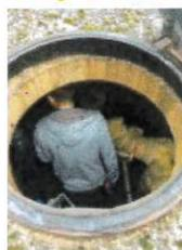
Les travaux d'installation de deux dispositifs de chloration sont en cours. Chaque jour, nous chlorons manuellement les deux réservoirs. L'installation d'une pompe à chlore sur chacun des réservoirs va permettre une chloration 'automatisée'.
